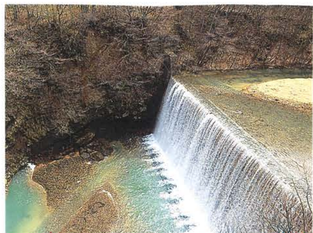
▲森の大橋 川上側。砂防ダムの滝です。落差は15mあります。
